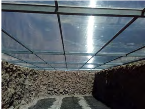
Invernadero con techo de policarbonato
